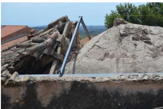
Figura 73. Imatge de la intervenció a la coberta l'any 2012. S'observa el morter superficial de la zona actualment no accessible. (Font pròpia)
