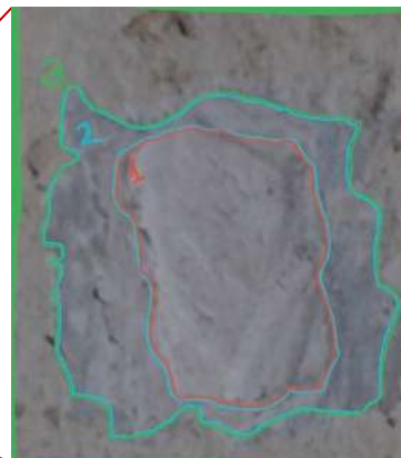
Figura 84. Cala de les capes d'encalcinat i morter de calç a la volta. (Font pròpia)
