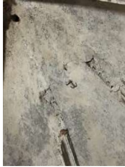
Figura 85. Imatge d'un clau de forja a les voltes de la nau central. (Font pròpia)
