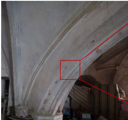
Figura 81. Zona de l'arc d'on es realitza la cala 1 de capes d'encalcinat. (Font pròpia)
