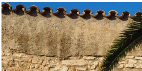
Figura 94. Taques al morter per la incipient aparició de pàtina biològica. (Font pròpia)
