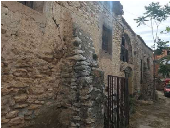
Figura 18. Façana lateral orientada al sud. Presenta intervencions posteriors que varia el seu estat original. (Font pròpia)
