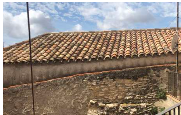
Figura 74. Imatge de la coberta actualment. (Font pròpia)
