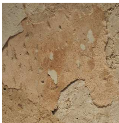
Figura 102. Imatge detall de la manca d'adherència de les diferents capes de morters. (Font pròpia)
