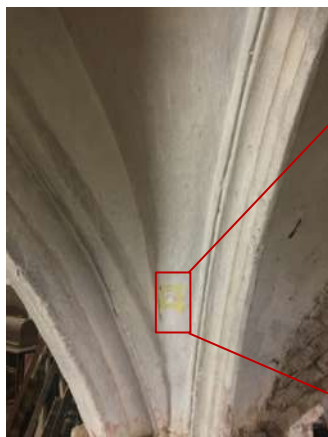
Figura 83. Zona de la volta de la nau lateral d'on es realitza la cala 2 d'encalcinats. (Font pròpia)
