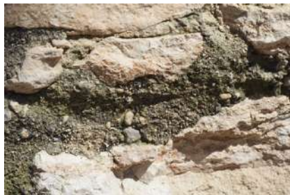
Figura 90. Atac microbiològic al morter de lligat. (Font pròpia)
