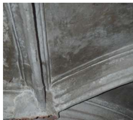
Figura 113. Pols dipositada als nervis de les voltes de la nau lateral. (Font pròpia)
