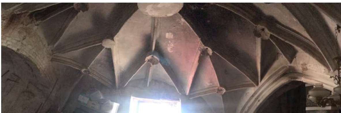
Figura 24. Voltes estrellades de la nau lateral. Hi manquen les claus de volta. (Font pròpia)
