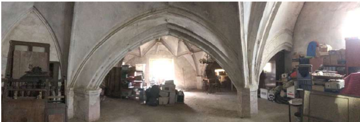
Figura 22. Arcs apuntats sobre els pilars de secció hexagonal. (Font pròpia)
