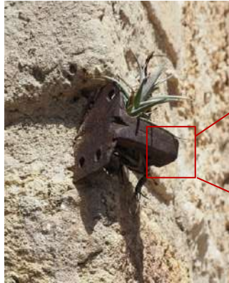
Figura 59. Element metàl·lic introduït a la façana exterior (Font pròpia)
