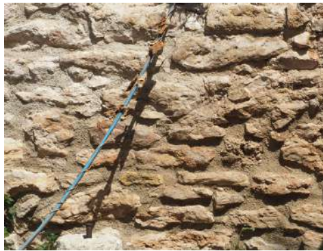
Figura 92. Enfosquiment dels materials de lligat i petris de la façana, a causa de la humitat. (Font pròpia)
