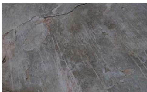
Figura 117. Regalims d'encalcinats posteriors a les voltes de la nau central. (Font pròpia)
