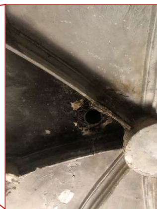
Figura 116. Detall de l'ennegriment al voltant d'una perforació a la volta de la nau lateral. (Font pròpia)
