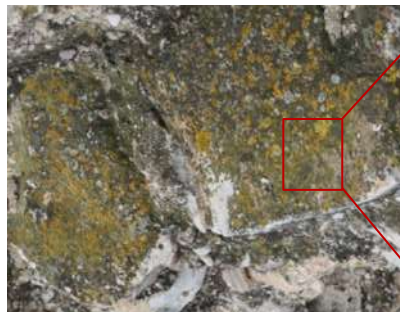
Figura 97. Atac microbiològic sobre el material petri de la façana nord. (Font pròpia)
