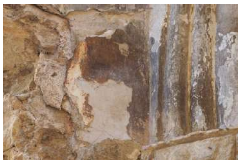
Figura 57. Diferents capes de revestiments i capes pictòriques posteriors a l'arc. (Font pròpia)
