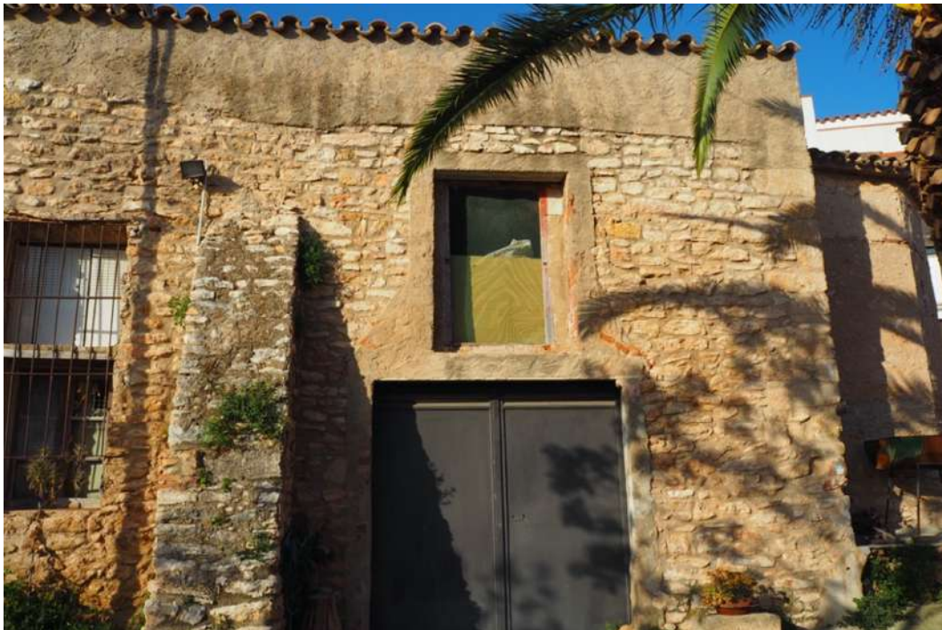
Figura 35. Imatge general de la façana sud de l'Església Vella, objecte d'estudi. S'observa el contrafort original i les diferents obertures. (Font pròpia)
