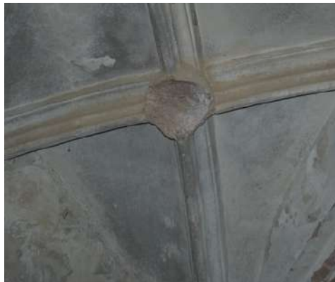
Figura 113. Pols dipositada als nervis de les voltes de la nau lateral. (Font pròpia)
