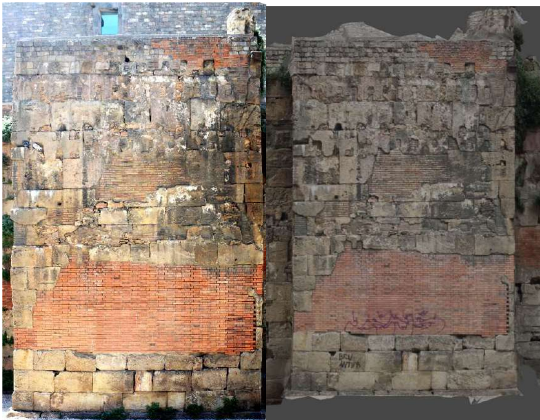
Fig 26-27. A la izquierda se observa la ortofotografía realizada a partir de una única fotografía en 2019. A la derecha se observa la ortofotografía capturada a partir del modelo fotogramétrico realizado en 2021
