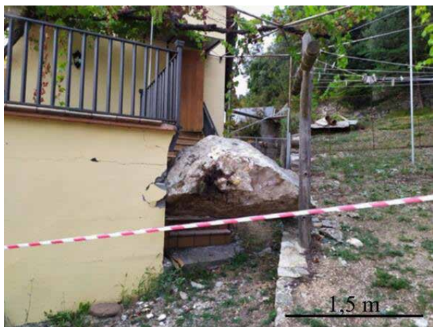
Fig. 6.- Bloque de aproximadamente 2 m 3 desprendido en septiembre de 2020 que impactó en la fonda Casanova.
