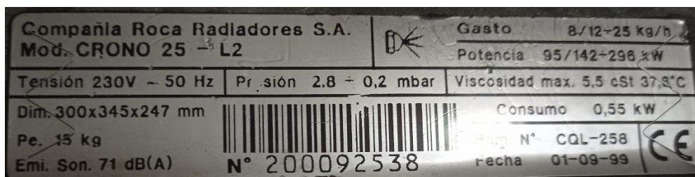
Ilustración 1: Placa de características de la caldera
