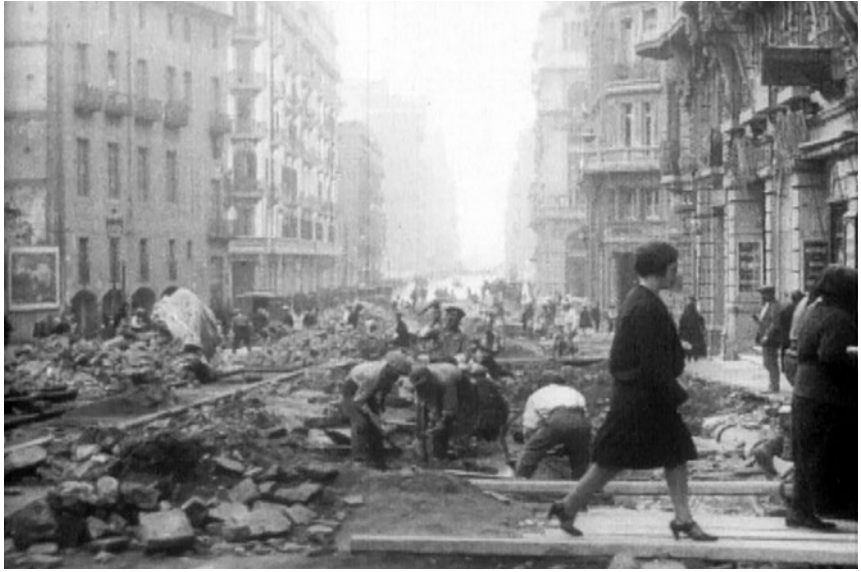
Obras en Via Laietana, fotograma de Barcelona se prepara para la exposición (1929). FilMOTECA de Cataluña.
