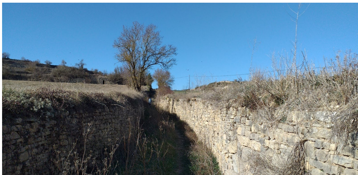
Imatge 4. El camí envoltat per murs de pedra seca a banda i banda a les afores de Santa Coloma de Queralt
