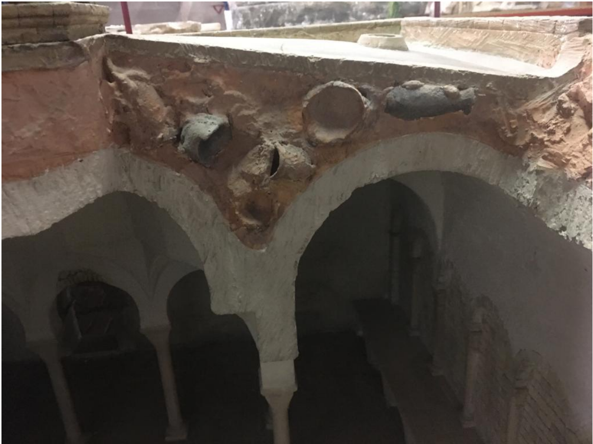
Fig. 13 Corte del edificio en la maqueta “Banyes nous” en el que se ve el material cerámico empleado en el relleno de la bóveda. MUHBA Centre de Col·leccions, MHCB 1095.
