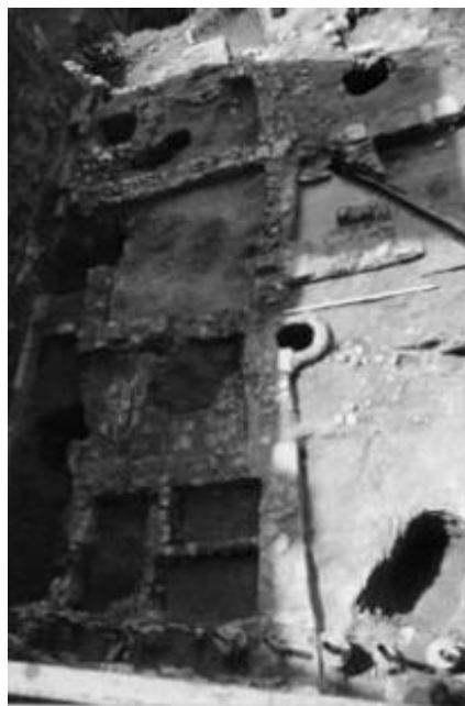
Figura 19. Fotografia de les estructures que conformen una casa amb pati d'època islàmica localitzada al Solar del Teatro Romano, és a dir, al c/San Jorge, 12-14. A la meitat dreta hi ha el pati i al nord d'aquest, la cuina. S'observa un pou d'aigua i un canal cobert (Galve, 2010: 174).
