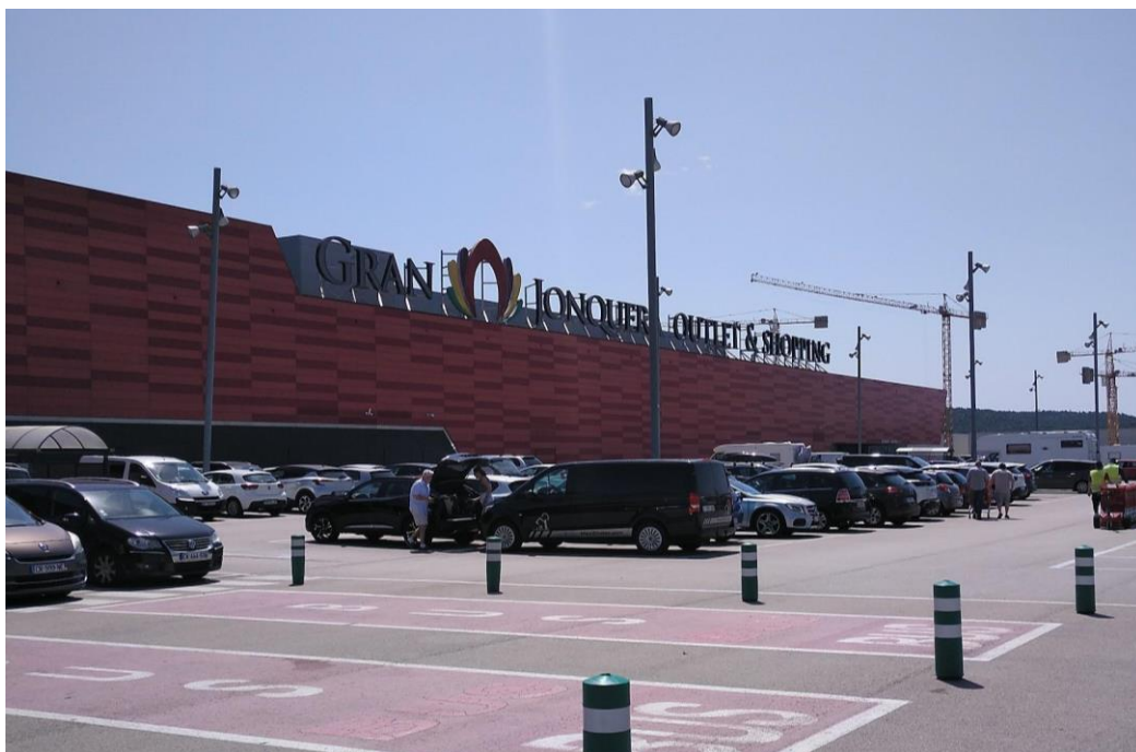
Figura 21: Façana i pàrquing del centre comercial Gran Jonquera Outlet & Shopping. Font: Elaboració pròpia el dia 11/06/2022 a les 12:12 hores.
