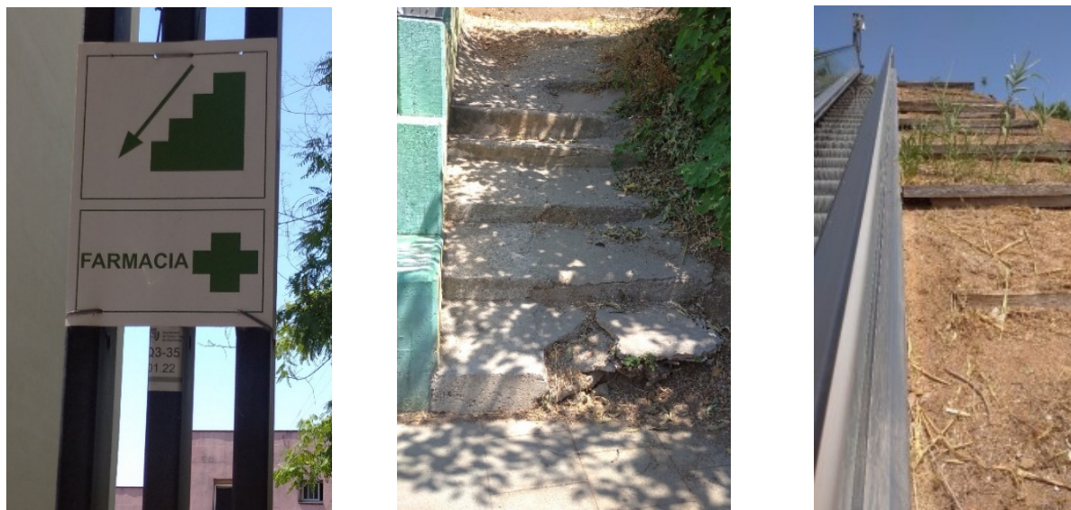
Figuras 13, 14 y 15. Señal indicando la dirección de una farmacia, unas escaleras en mal estado y escaleras mecánicas al lado de las escaleras de autoconstrucción en Les Oliveres y Singuerlín.
