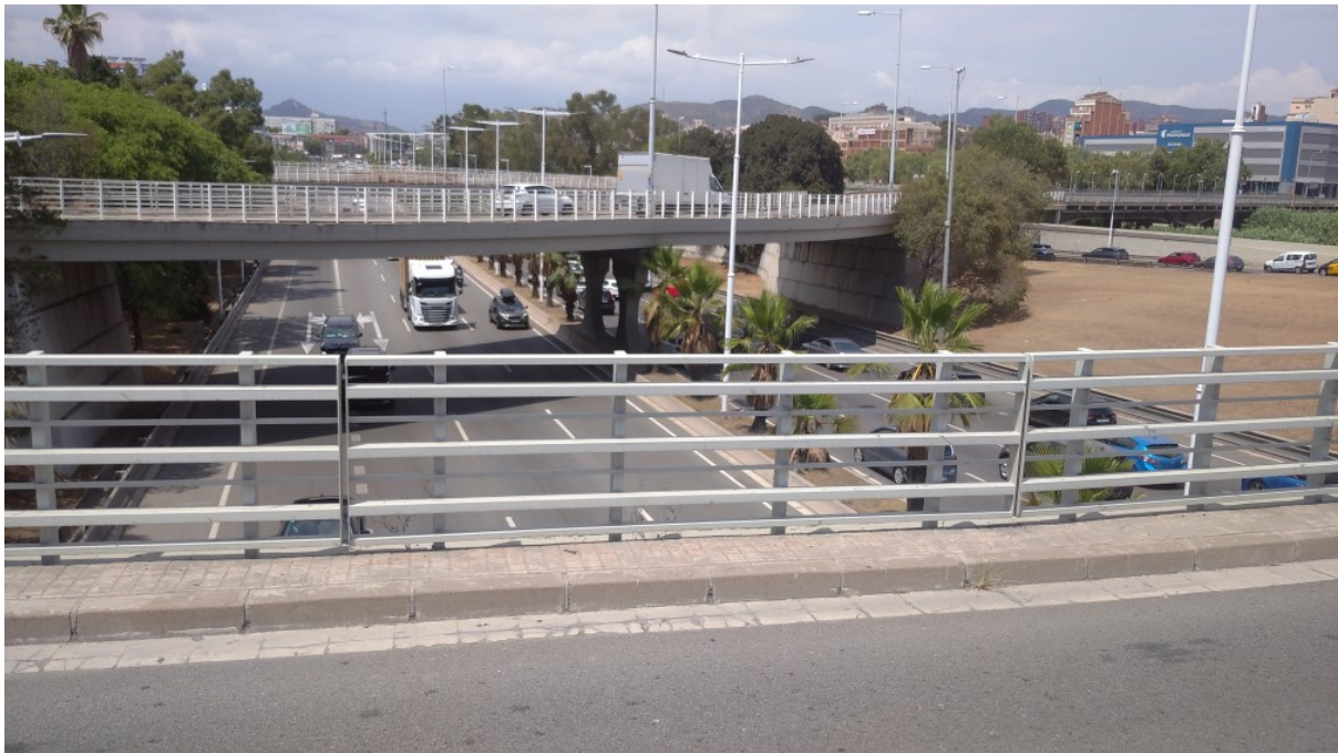
Figura 1. Desde el puente de entrada de la ronda y el doble puente que conecta rambla Guipúzcoa con la av. Alfonso XIII, a la derecha se aprecia el río y por debajo de los puentes la Ronda Litoral.
