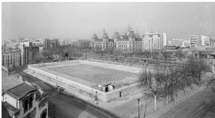
Figura 21. Solar resultant de l'enderroc del Palau de Belles Arts. [1948]. Font: Barcelofília.
