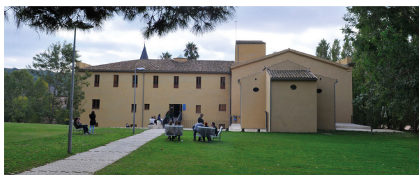
Campus de l'Alimentació de Torribera, a Santa Coloma de Gramenet.
