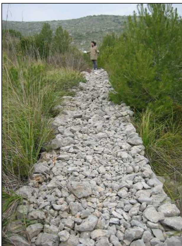
Figura 8. Muro de doble cara y gran amplitud
