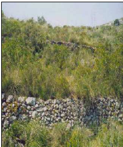
Figura 12. Mur de contenció de terrassa.
