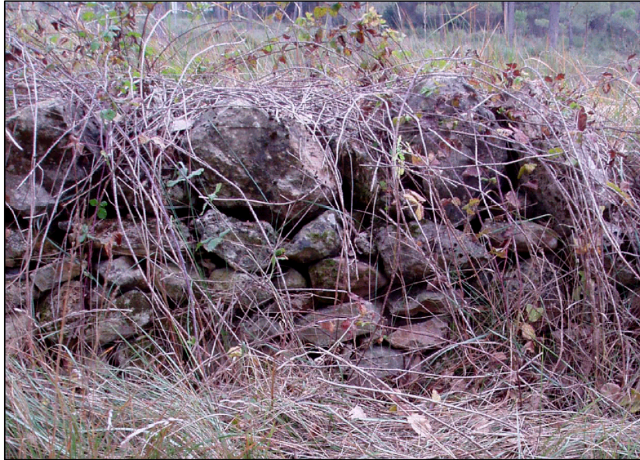
Figura 5. Mur de delimitació del camí de La Clota, estructura I.
