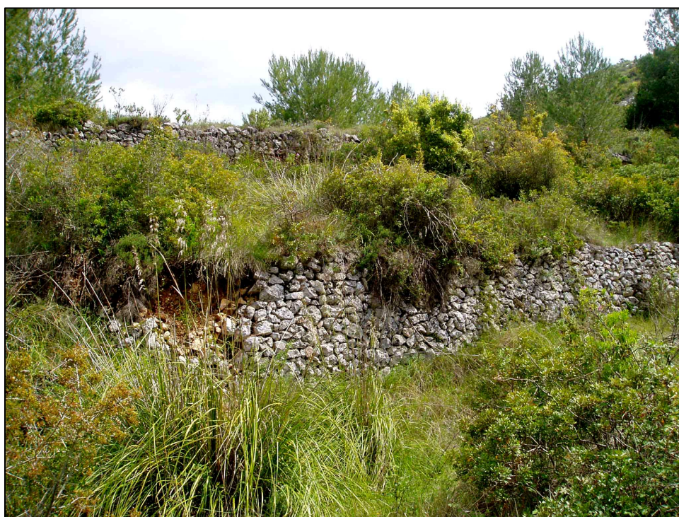
Figura 28. Morfologia dels murs de contenció de les terrasses de 2ª generació.
