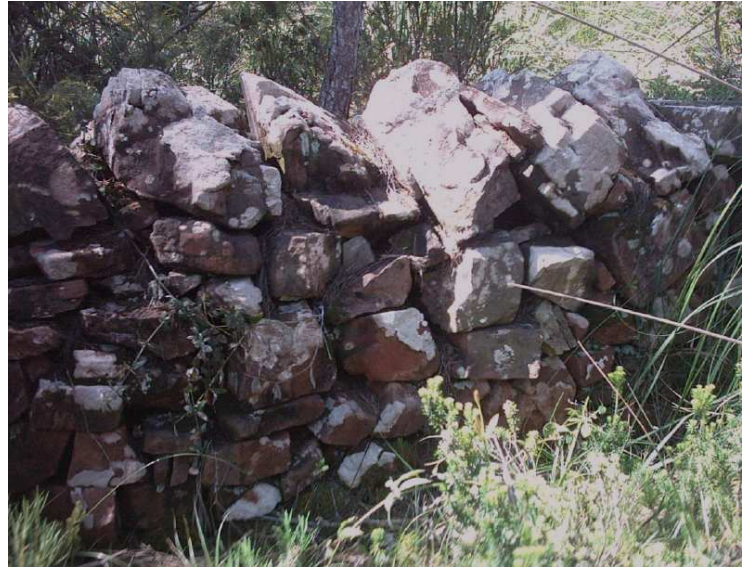
Figura 7. Muro a doble cara del camino de Térmens a la Maçana. Su tipología resulta característica de los caminos ganaderos de la zona.
