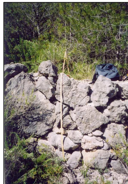
Figura 30. Tècnica constructiva de terrasses de 1 a generació.
