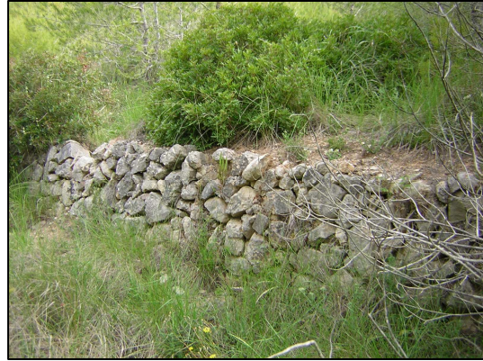
Figura 35. Gran mur de tancament del sector 103.
