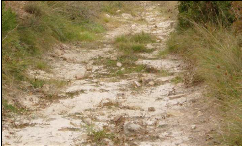
Figura 3. Vista de l'estructura I, camí de La Clota.
