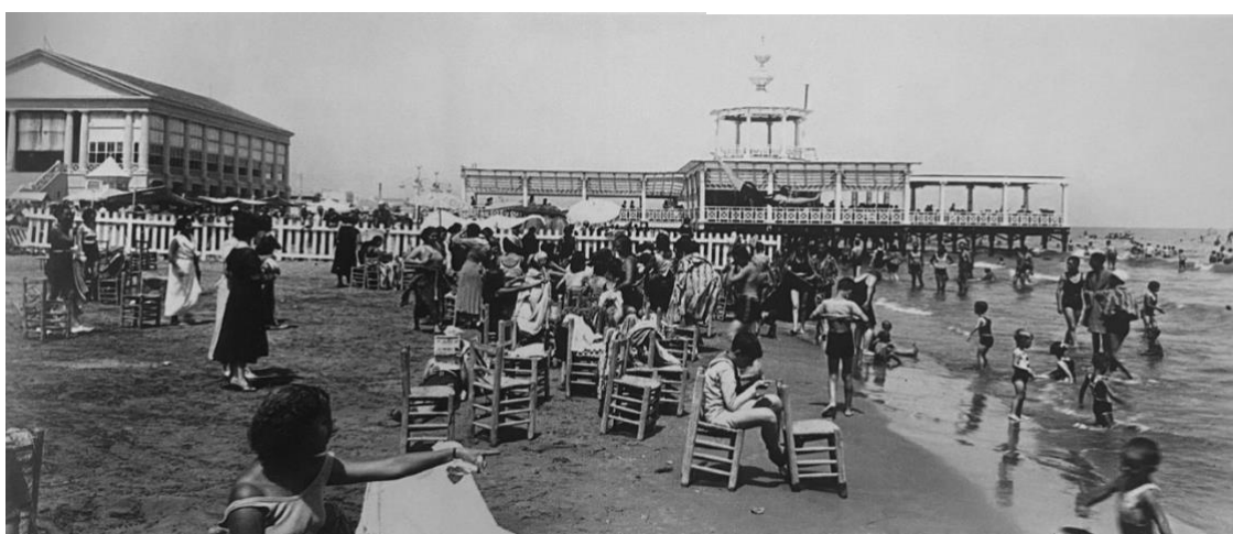
Fig. 27. Vista de la playa valenciana, en la que se puede ver la valla mencionada, así como el Pabellón de Cortina, ca. 1925. València. (Extraído de: Muñoz Vidal, “Ocio marítimo...”, 223).
