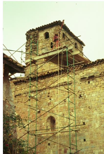
Figura 8. Obres de restauració al campanar de l'església. Font: Solà, P., 1994, Generalitat de Catalunya, Àlbum fotogràfic de les restauracions
