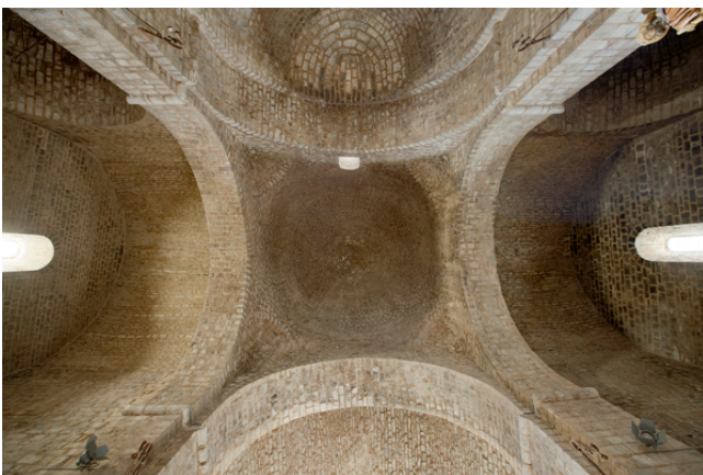
Figura 18. Vista interior del creuer amb la cúpula de trompes. Font: Mayer, P., 2010, https://polmayer2.locloudhosting.net/items/browse
