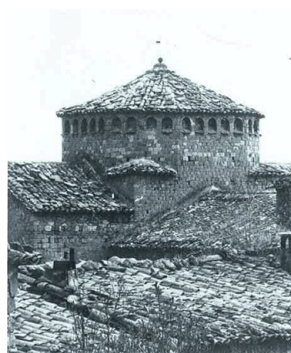
Figura 10. Vista del cimbori de l'església de Sant Jaume de Frontanyà l'any 1965. Font: González, Antoni et al. La restauració, ara i aquí . Barcelona: SCCM, 1983, p. 64
