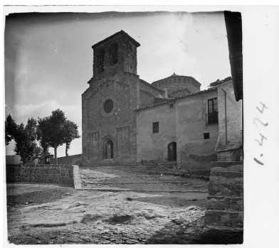
Vista de la façana principal i la rectoria adossada al lateral sud de Sant Jaume de Frontanyà. Biblioteca de Catalunya: Fons Salvany, 1918
