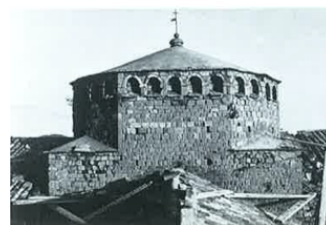
Figura 11. Vista del cimbori de l'església de Sant Jaume de Frontanyà l'any 1975. Font: González, Antoni et al. La restauració, ara i aquí . Barcelona: SCCM, 1983, p. 64
