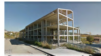
Figura 68. Edificio inconcluso (2022). Berga, España. Extraído de: https://english.habitaclia.com/investments-berga.htm
