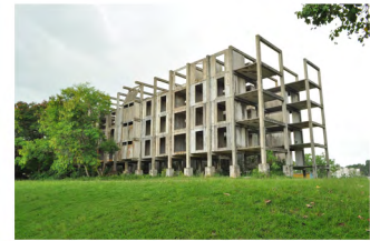
Figura 87. Edificio inconcluso (2020). La Habana, Cuba. Imagen tomada por el autor
