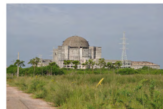
Figura 13. Estructura arquitectónica inconclusa, Cienfuegos, Cuba (2020). Imagen tomada por el autor
