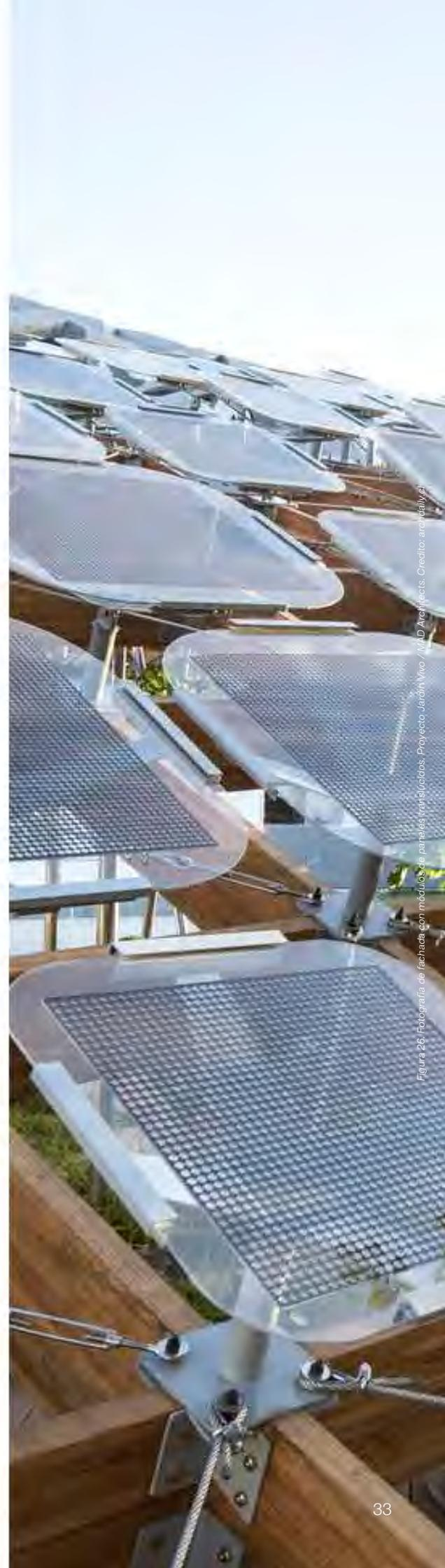
Figura 26. Fotografía de fachada con módulos de paneles transparentes. Proyecto Jardín Vivo / W&D Architects. Crédito: arqh4lyz
