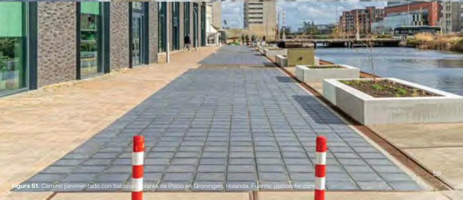
Figura 51. Camino pavimentado con baldosas solares de Platio en Groningen, Holanda. Fuente: platio solar.com
