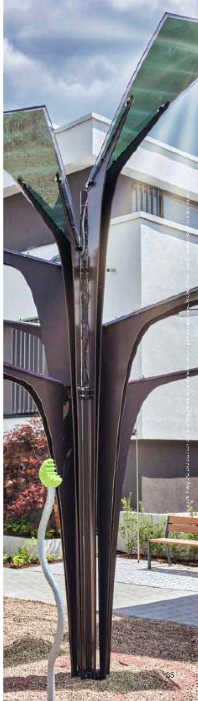
Figura 28. Fotografía de árbol solar para bicicletas eléctricas con paneles solares orgánicos integrados. Proyecto Solar Tree for e-bikes / ASCA. Creador: ascaco
