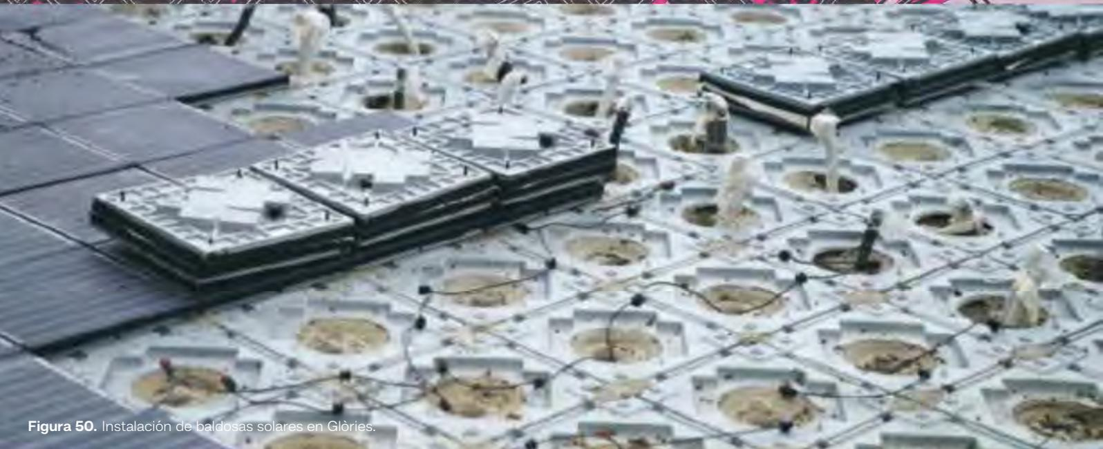
Figura 50. Instalación de baldosas solares en Glòries.
