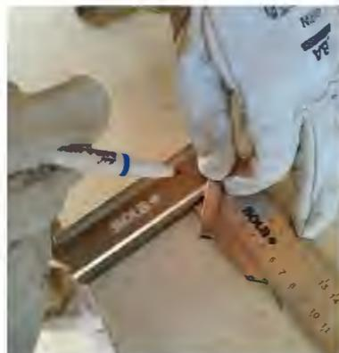
FIGURA 22 . Corte con radial de todo el material necesario.
