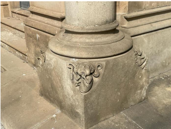
Fig. 61, 62 i 63. Detall de capitell florit de la columna de la façana principal i del pedestal i basa de la mateixa. Al costat, detall del lateral esquerre de la façana principal.
