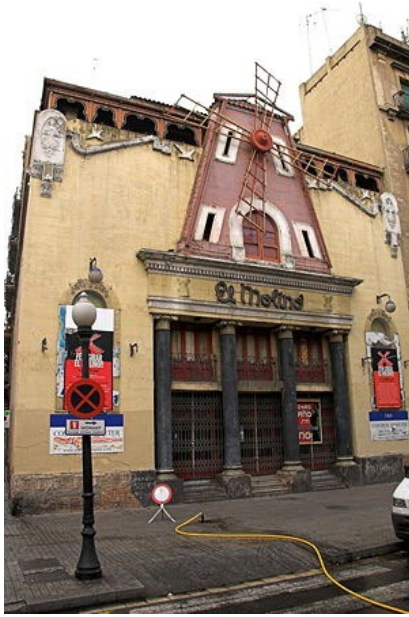
1.2.C.5.1. Fachada del antiguo El Molino
