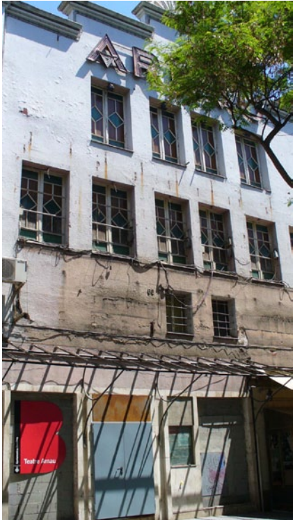
1.2.C.1.6. Fachada del Teatre Arnau
