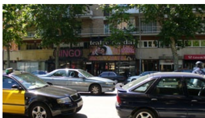
1.2.C.6.1. Fachada del Teatre Condal
