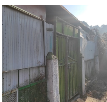
Figura 18. Entrada a un parcela de formigó amb reixa de metall. Font pròpia
