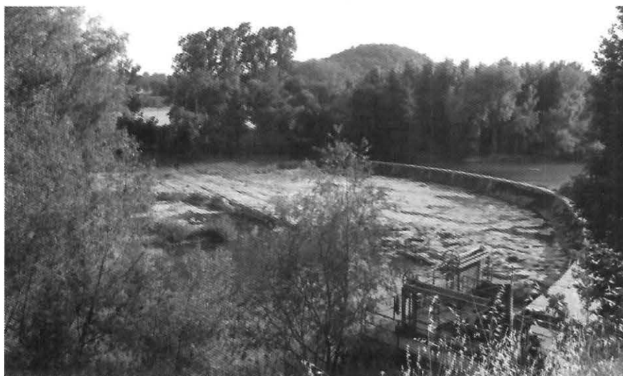
La resclosa de la Teula amb les comportes. (Font: Arxiu propi)
