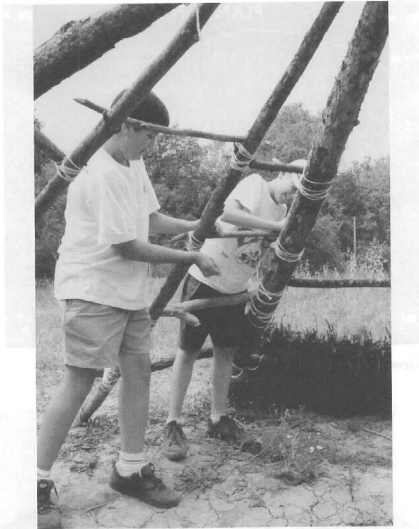
Figura 5.3.1.d Proceso de construcción de la cabaña
