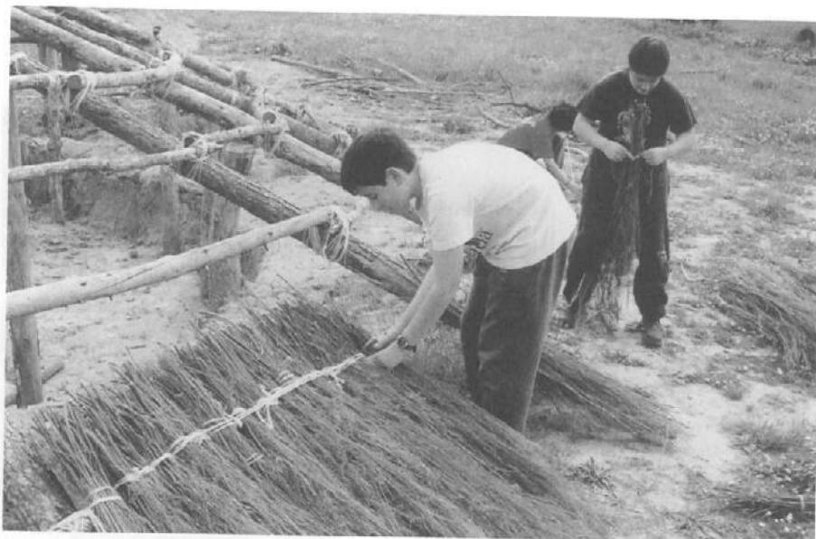
Figura 5.3.1.d Proceso de construcción de la cabaña
