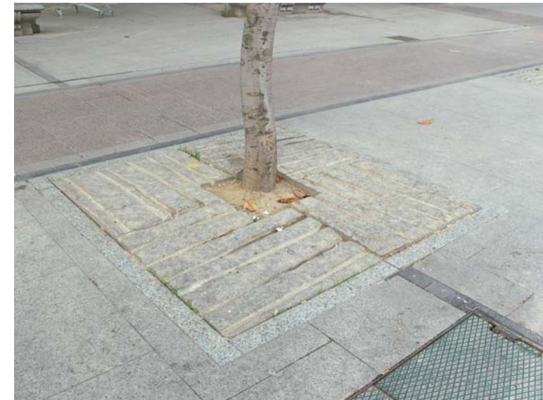
Saragossa. Tractament específic dels escorrells a la Plaça del Pilar
