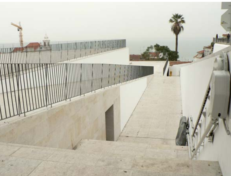
Lisboa. Superació de barreres d'accessibilitat en una recent intervenció al largo das Portas do Sol
