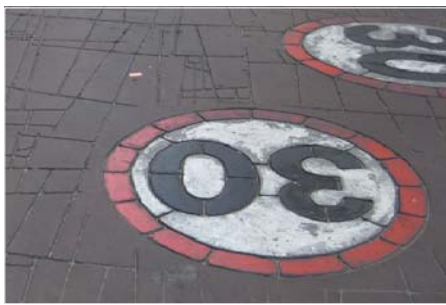
Asfalt imprimat. Exemple pavimentació zones 30 Sant Andreu>
