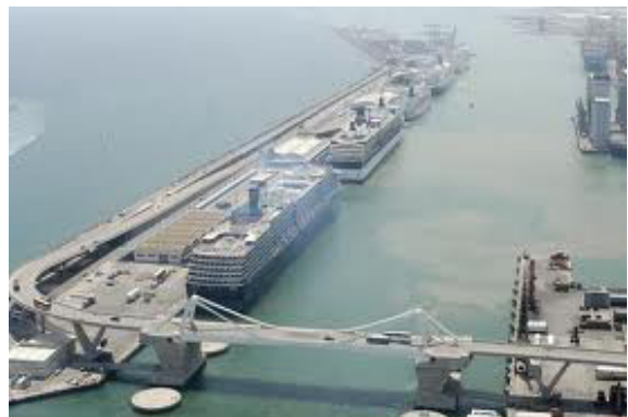
Figura 1.34: El puente levadizo Porta d'Europa para conectar el muelle adosado y el nuevo Puerto de cruceros fue una obra de vital importancia para el incrementar el número de cruceristas.
