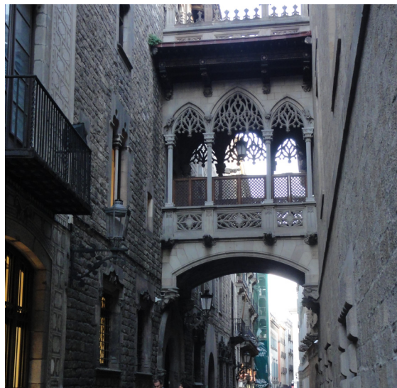
Figura 2.65: El puente neo-gótico de la calle del Bisbe data de 1928, y es obra de Joan Rubió, discípulo de Antoni Gaudí.
