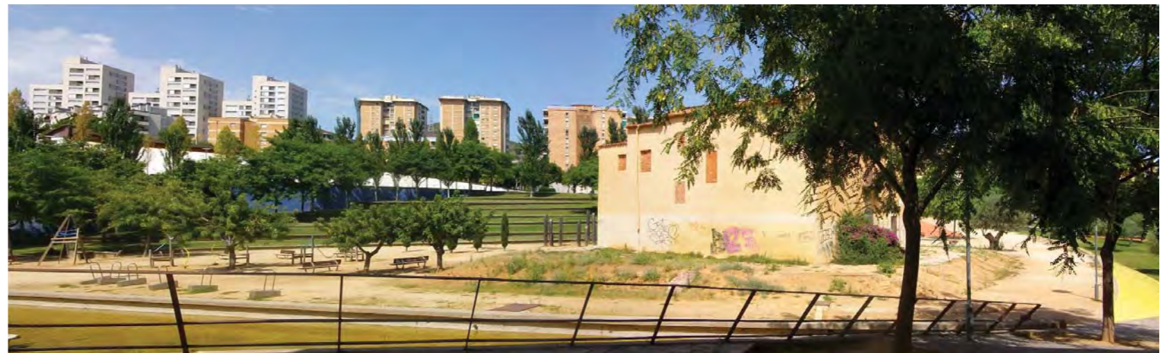
Masía de Can Carreres, preservada como elemento de memoria del pasado agrícola de la zona dentro del espacio del Parc Caentral de Nou Barris.
