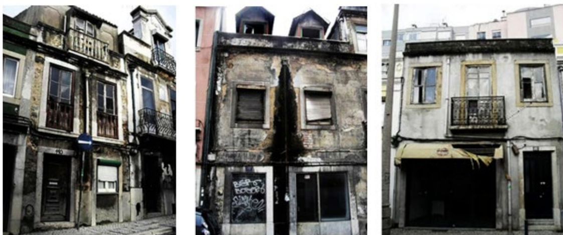
Imagem 65: Exemplos de edifício degradado na Rua do Lumiar
