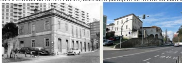
Imagem 19: Vista da Alameda de Linhas de Torres à Rua do Lumiar. A Este a Quinta dos Lilazes e a Quinta das Conchas
