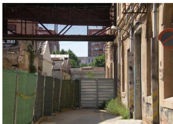
Fig. 25. Can Ricart en mayo de 2011. La paralización del proyecto Casa de les Llengües compromete las obras del edificio, que tiene desprotegida su estructura. Imagen inferior: la entrada de Hangar.
