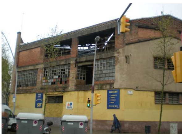
Fig. 34. Vacíos urbanos (2011). Arriba: solar en los antiguos terrenos de Transportes Trío, ahora usado como parking improvisado. Centro: Solar cerrado en espera de construcción. Es la tipología preferida para establecer viviendas precarias por estar protegido de la calle. Abajo: edificio desocupado.
