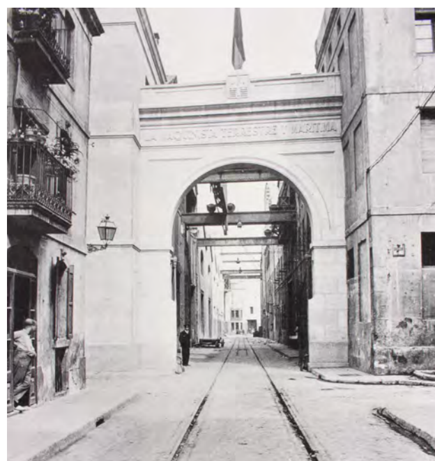
Fig. 1.5 Antigua entrada de la fábrica de la Maquinista Terrestre y Marítima, actual acceso a la plaza Pompeu Genèr.
