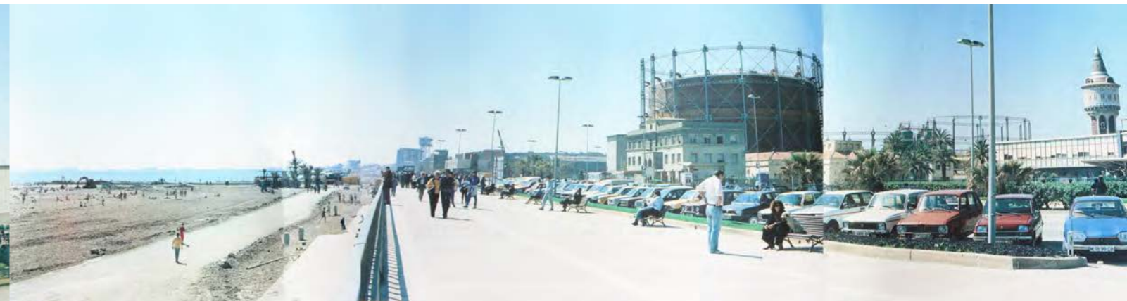
Fig. 2.3 Vista del Paseo Marítimo de la Barceloneta con las instalaciones de la fábrica La Catalana de Gas de fondo.
