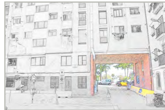
Fig. 3.17 Paso inferior hacia el Paseo Marítimo.
