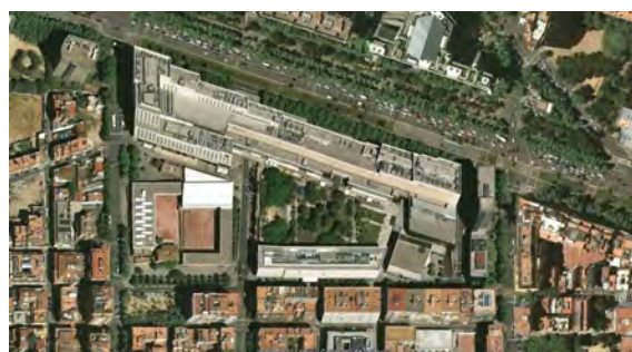
fig. 3.25 Fotoplano 2009, conjunto de L'illa Diagonal terminado.
