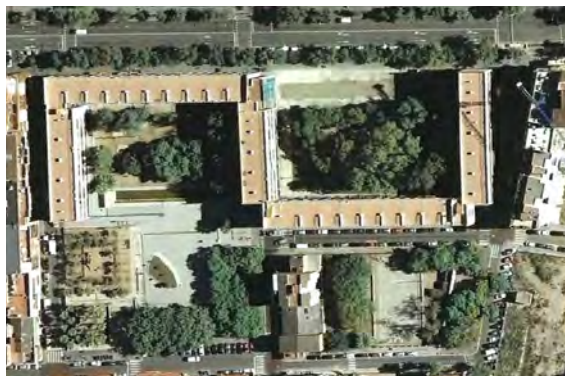
fig. 3.12 Fotoplano en 2007, previo al derribo del “Bloque Fantasma”. fig. 3.13 Fotoplano en 2010, que muestra la huella del vacío posterior al derribo.
