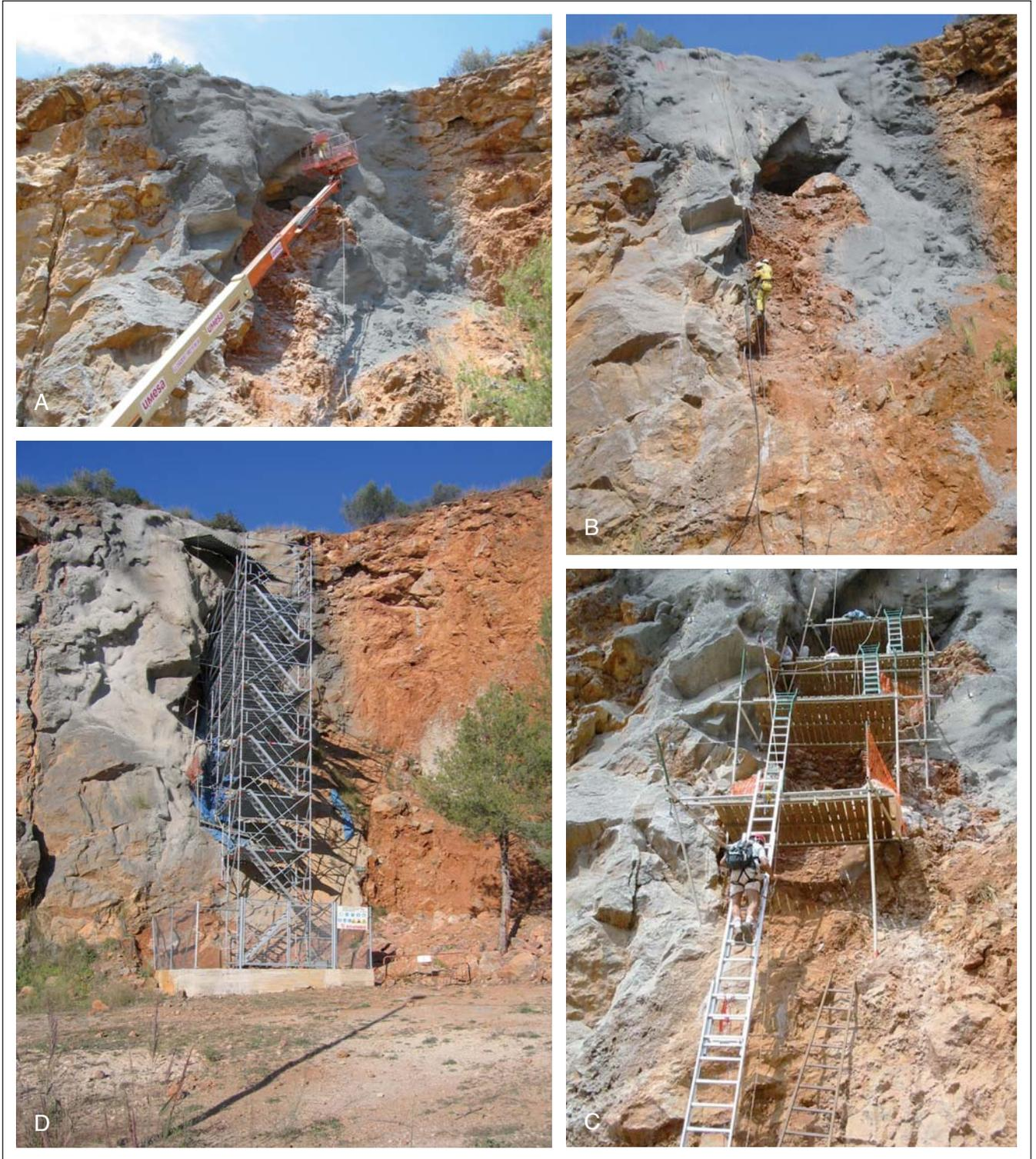
Fig. 5. Proceso de los trabajos de rehabilitación del yacimiento. A. Protección de los sedimentos, instalación de mallazo y proyectado de hormigón. B. Instalación de bulones de anclaje. C. Andamio de acceso provisional (años 2003-2006). D. Estado actual del yacimiento.
