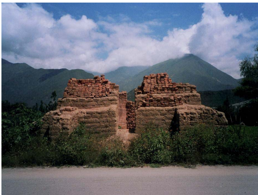
Callejón de Huaylas, Ancash. Ladrillera que revela su contenido. Sus formas se relacionan con la forma piramidal de los cerros circundantes. Cuando el horno deja de funcionar, permanecen en el paisaje como vestigios de las labores del hombre en el territorio. (foto: V. Crousse)
