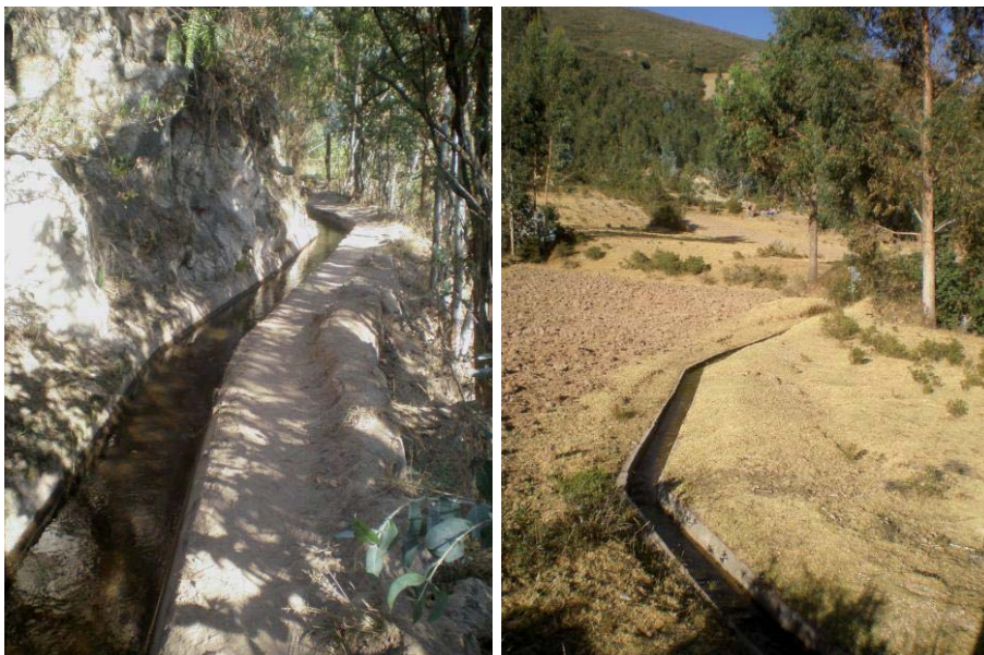
Camino a Huanta, Ayacucho. Estos canales de regadío tienen una gran semejanza con los recorridos del acueducto de Cumbemayo. Sus líneas sinuosas revelan una voluntad y necesidad de adaptarse a las ondulaciones del terreno. (foto: V. Crousse)
