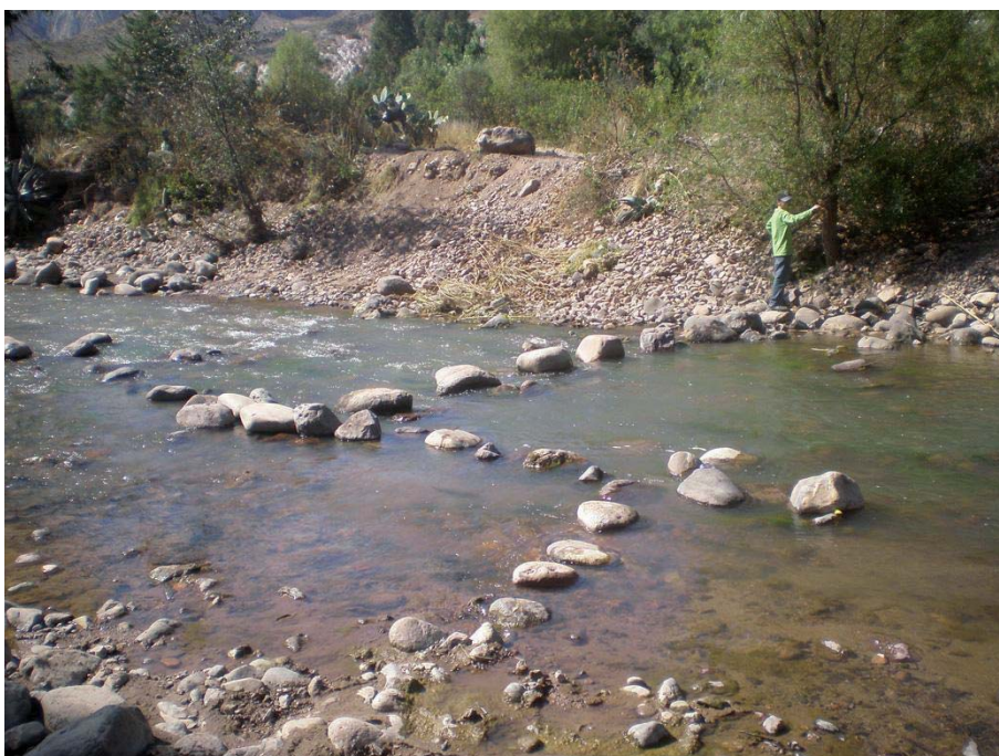
Niño Yucaes, Ayacucho. Puente de piedras en el río. La necesidad de no oponerse a la corriente en su punto central, donde el caudal es más fuerte, obliga a adaptarse a esta dificultad generando una configuración escalonada de las piedras, que convierte este puente en algo singular. (foto: V. Crousse)
