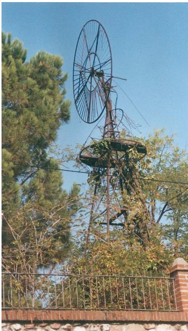
Molino de viento, perteneciente a la finca de Can Fonolleda, formado por una torre con castillete circular de estructura metálica. Sobre ella se levanta una gran rueda de aspas giratorias instalada sobre un sofisticado mecanismo de engranajes, todo ello también del mismo material.
