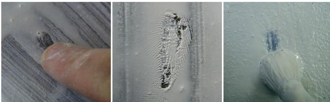
Figura II.11. Pérdida de la capa de papilla mediante percepción táctil y luego con pincel, debido a un mal secado.
