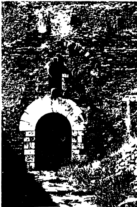
FIG 205 PORTAL D'INGRES AL CLAUSTRE
