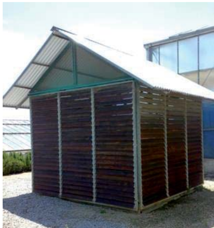
Figura 1.5. Insectario. Estructura techada construida con láminas de madera que simula las condiciones ambientales del campo pero sin la radiación solar directa ni la precipitación.
