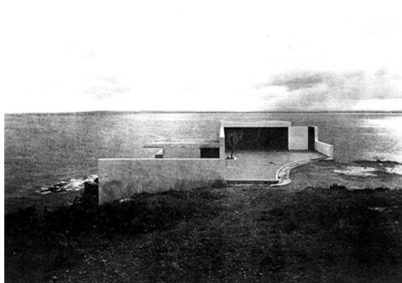
Fig. 50: acceso de la casa Rozes.
