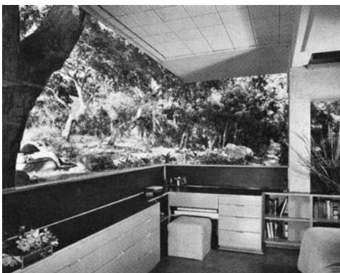
Figs. 30 y 31: casa Tremain, Santa Bárbara, 1947, Neutra. La limpia solución de la ventana en esquina permite que desaparezca la separación entre el interior y el paisaje circundante.
