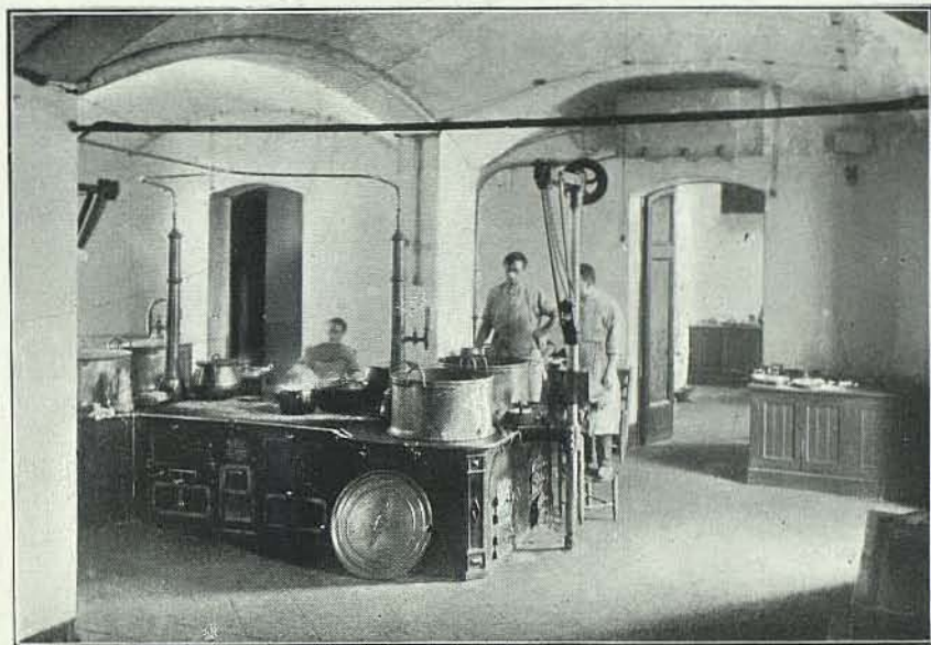
Cocina del Hospital Clínico
