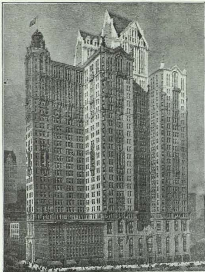
Fig. 44.— Alturas consentidas por la construcción americana con Skeleton de acero
