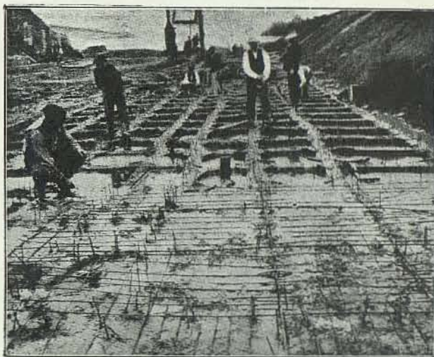
Fig. 37. — Fundaciones por el cemento armado de una sala de máquinas en terreno fangoso — Ingeniero: Ribera
