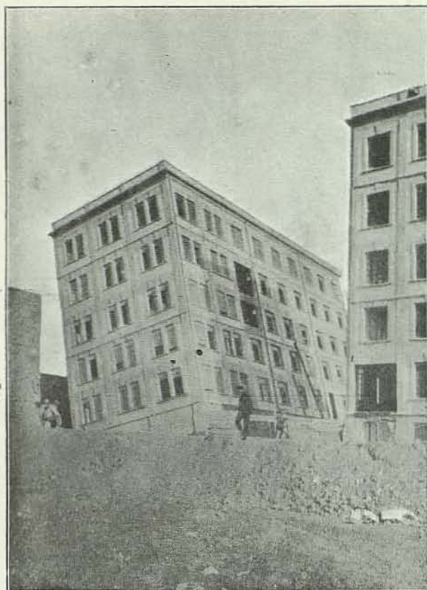
Fig. 56.—Demostración de la resistencia del cemento armado en caso de hundimiento de cimentaciones
