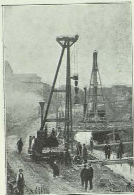
Fig. 38. — Fundaciones de los estribos de un puente por el sistema mecánico « Compressol »
