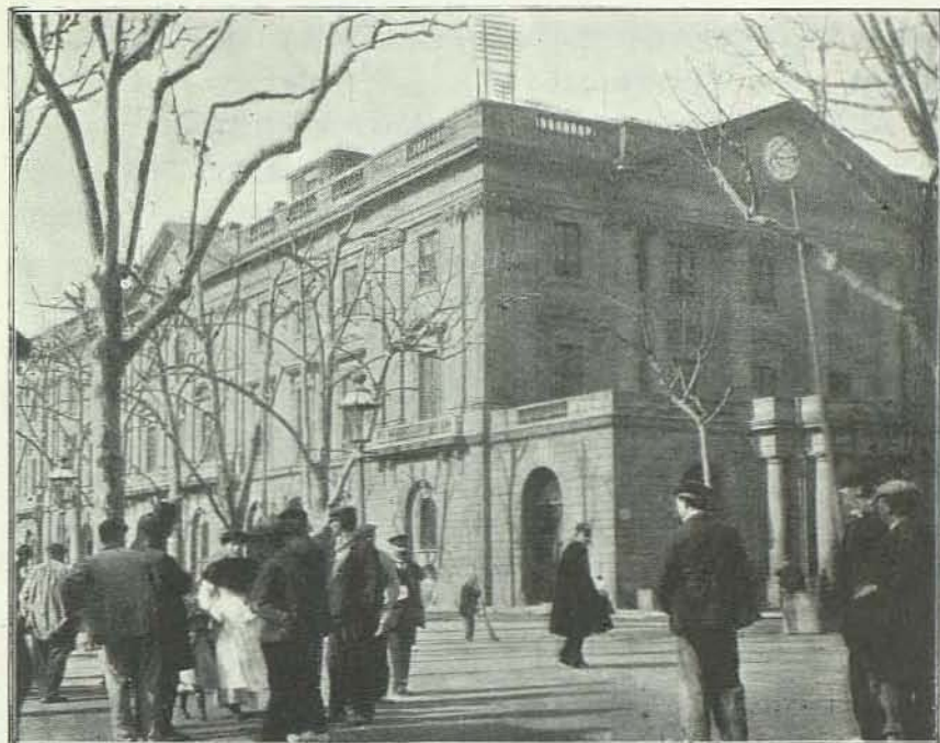
Edificio de la Casa Lonja
