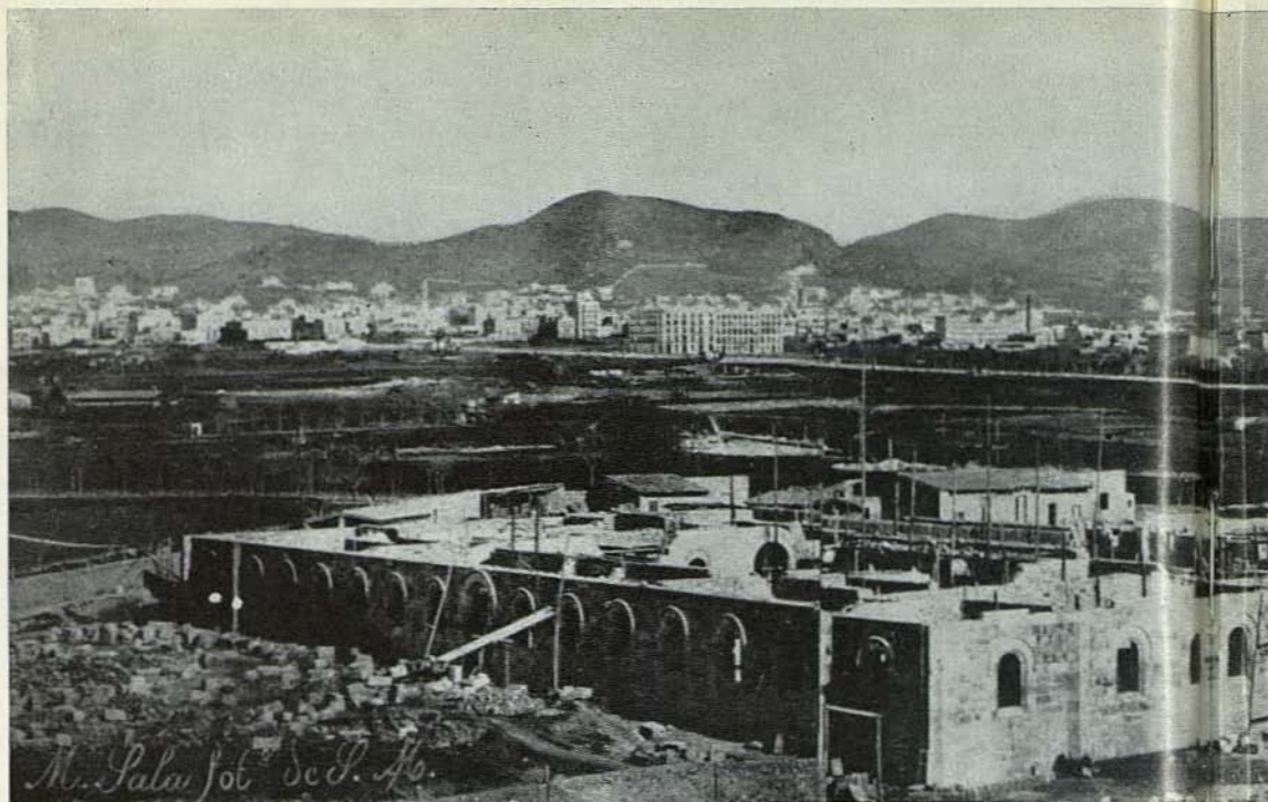
Estado de las obras del edificio de
