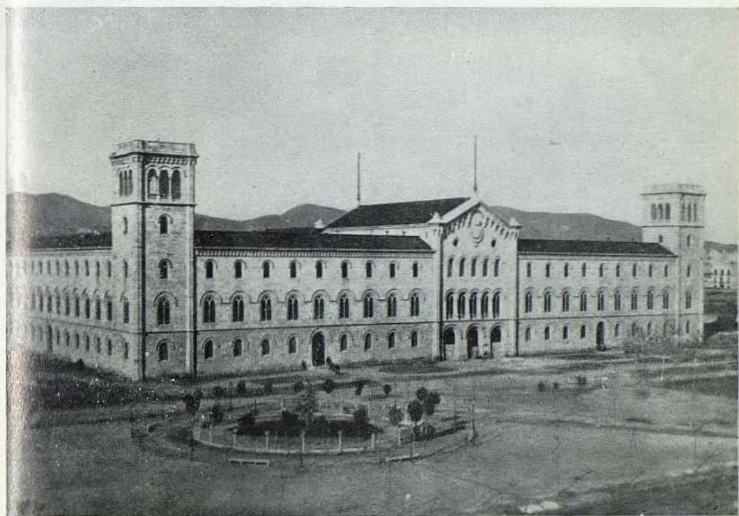
Edificio de la actual Universidad a punto de terminarse su construcción en 1873 en la que se ha denominado plaza de la Universidad.
