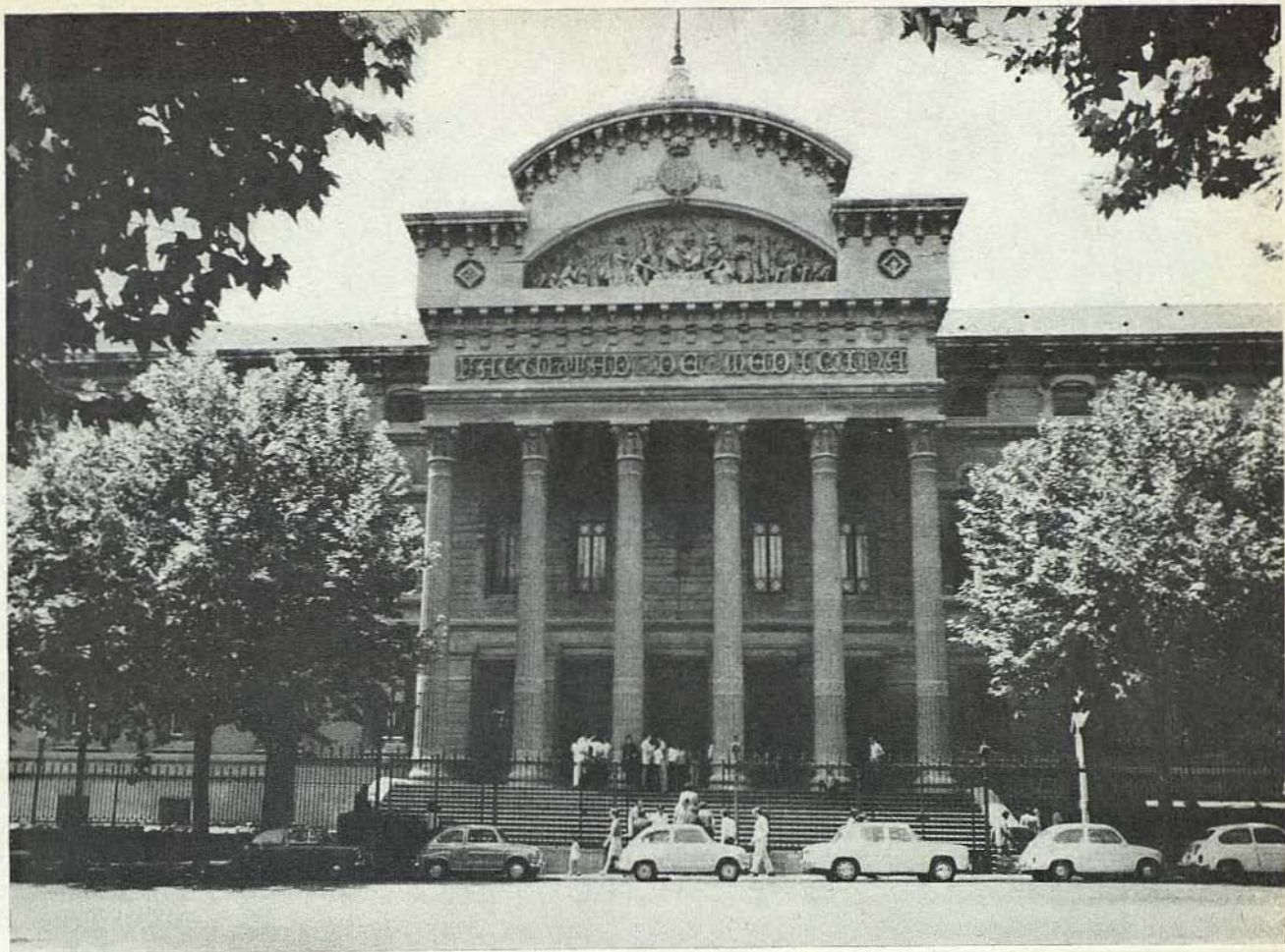
Edificio de la Facultad de Medicina junto al Hospital Clínico situado en la calle Casanova.
