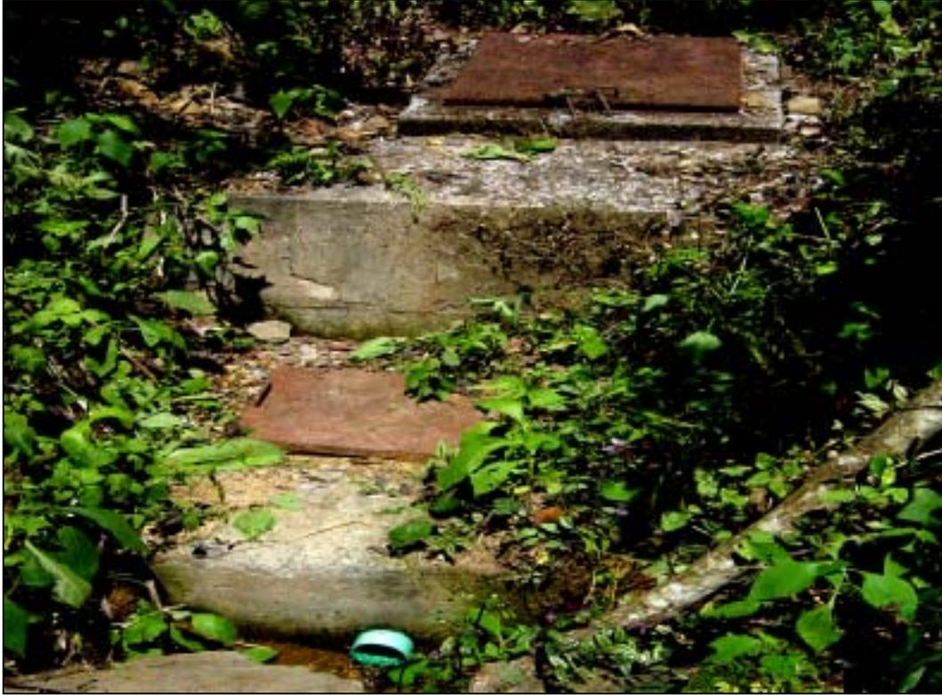
**Foto 43: Toma de agua artesanal para un conjunto de viviendas. La forma en que ha sido construida, no asegura una buena calidad del líquido.**
