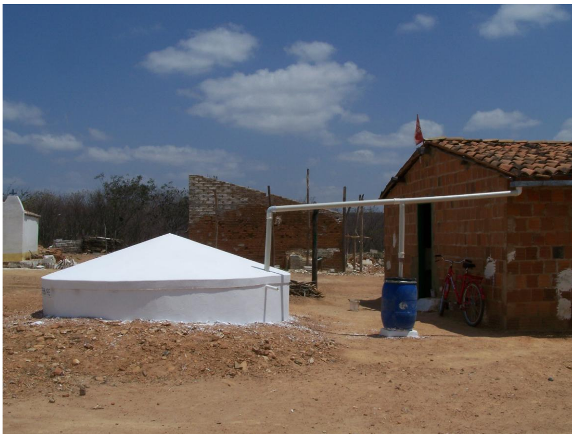
Foto 18 – Cisterna de placa concluída
