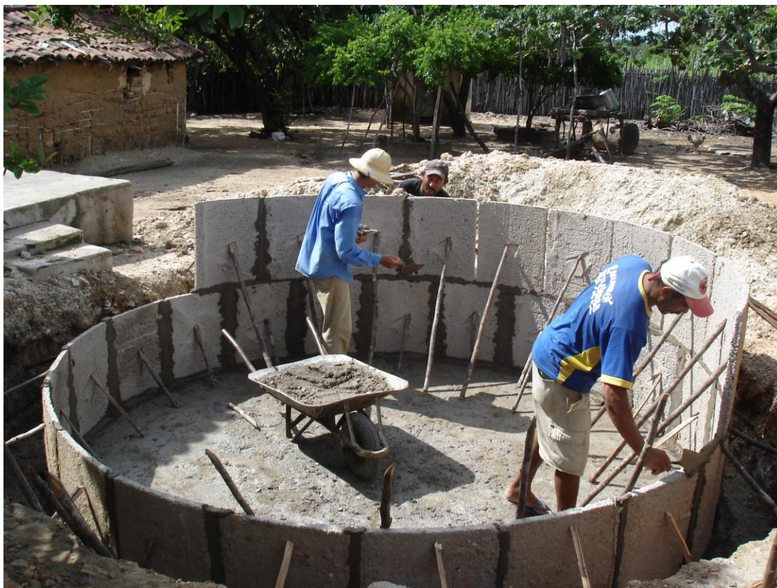
Foto 17 – Cisternas de placa com capacidade para 16.000 l em obra
