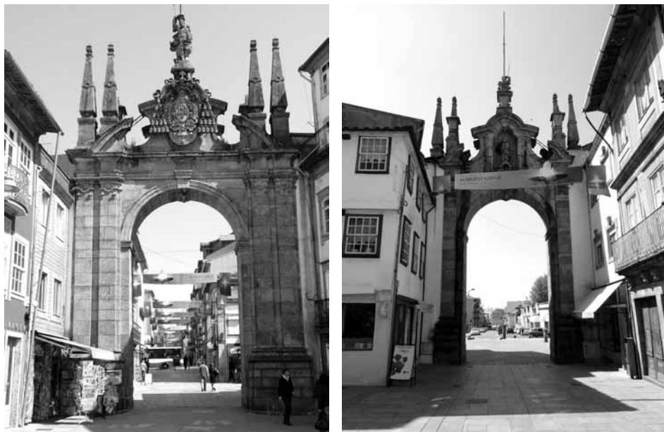
56. Arco da Porta Nova, Braga Segundo o Sistema de informação para o património arquitectónico do IHRU (Consult. 1.Dez.2010), trata-se de uma monumentalização da antiga Torre da Porta Nova, à qual foi dada a feição de um arco triunfal barroco. Note-se o tratamento diferente para o interior e para o exterior.
