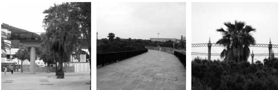
88. Estrutura em viaduto no actual Parc de la Barceloneta
