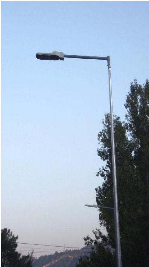
Fig.32 Columna vial con luminaria de leds. 119
