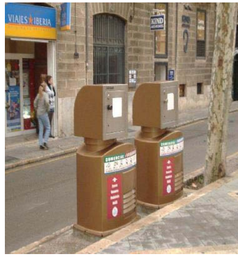
Fig.25 Sistema de recogida de basuras por medio de aspiración.
