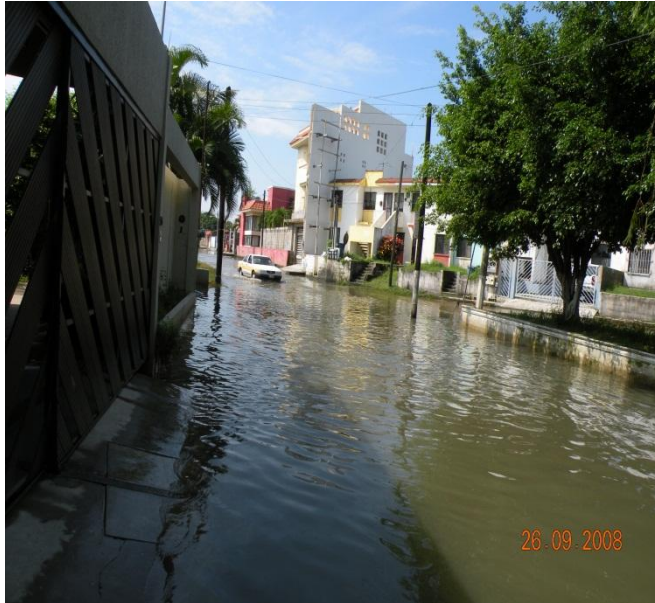
Figura. 121. Desbordamiento de la Laguna La Ilusión con afectación en la Colonia Ampliación Unidad Nacional de Ciudad Madero. Septiembre del 2008. FUENTE: Propia.
