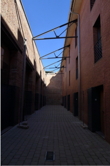
Ftg 1- 49 Vista del paseo creado entre dos naves.
