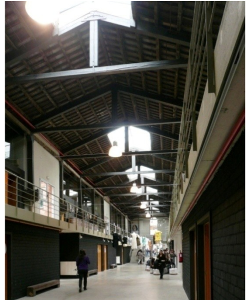
Ftg 1- 45 El interior de la BAU, se ven las estructuras originales de la nave.
