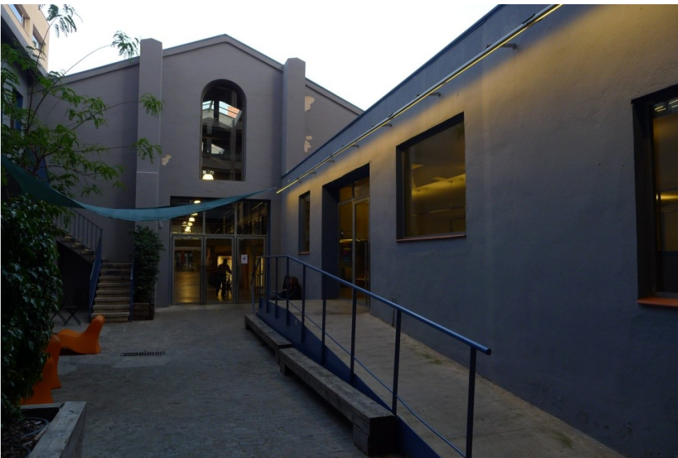
Ftg 1- 46 Imagen actual, el patio a la entrada de la BAU
